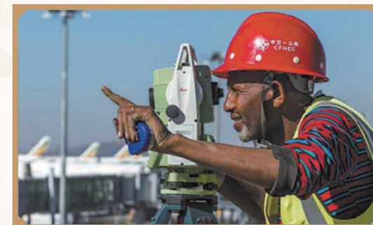
• 中交一公局外籍雇员正在博莱国际机场新航站楼进行勘探施工作业
